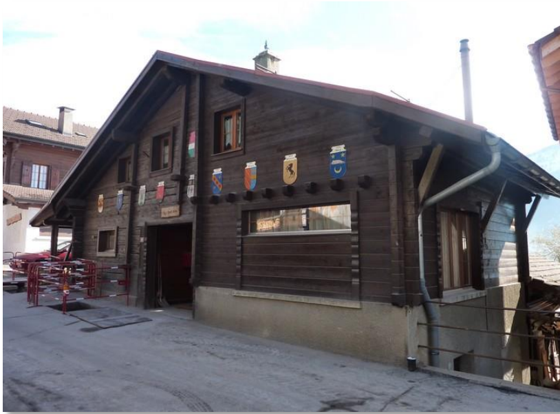
Facade en madrier, réfection en 2010
